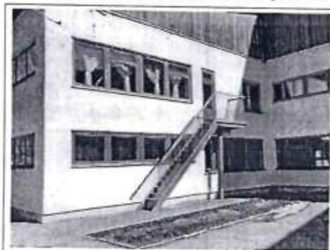
Фото 1 – Общий вид окон
