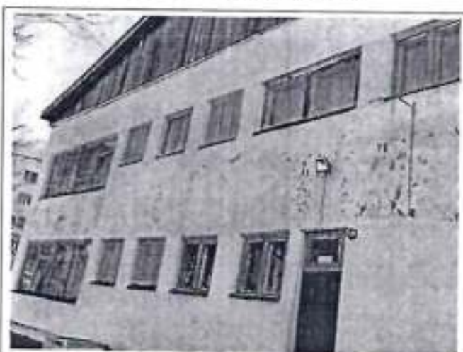
Фото 3 – Общий вид окон
