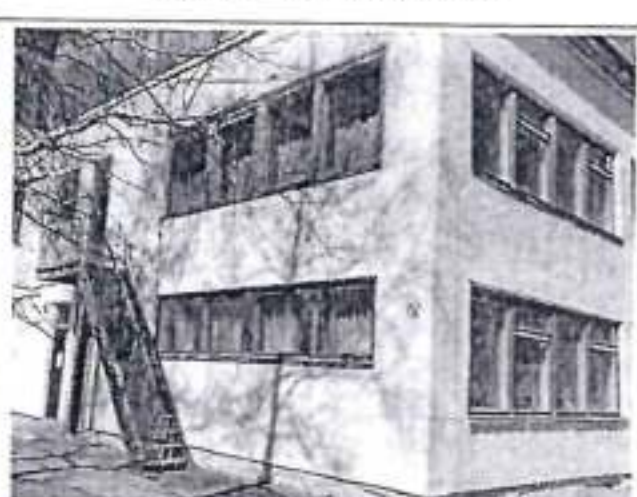
Фото 4 – Общий вид окон
