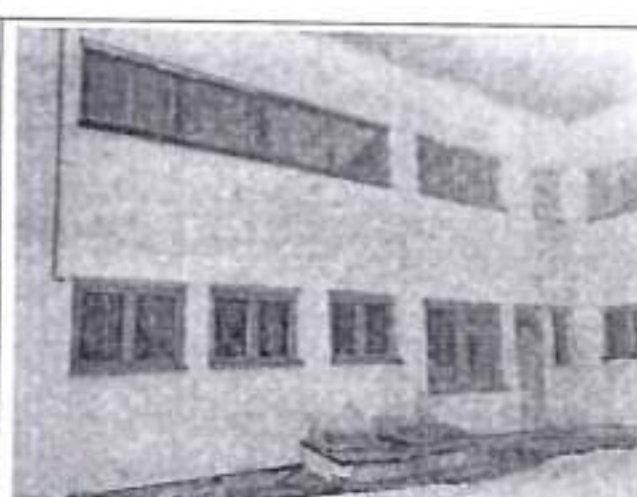
Фото 2 – Общий вид окон
