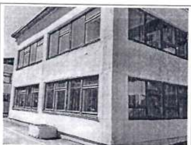
Фото 5 – Общий вид окон
